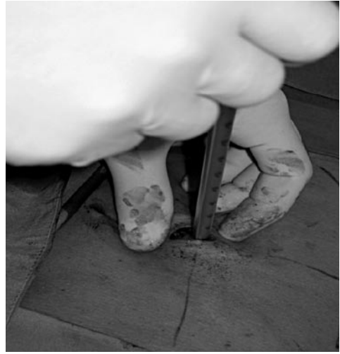
Figura 4. Posizionamento del drenaggio.
